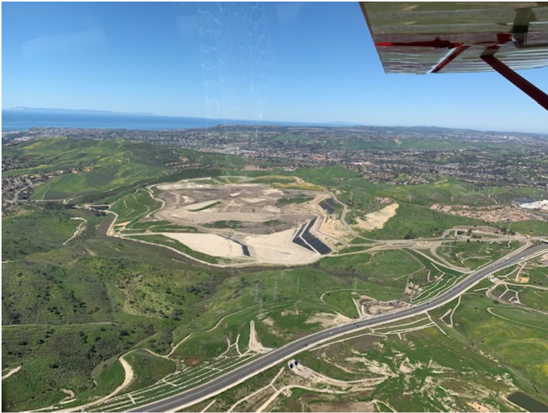
Prima Deshecha Landfill
